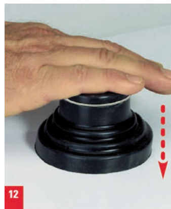
12. Dichtungsmanschette von oben bis zum Aufsitzen aufschieben, ohne diese zu überdrücken.
