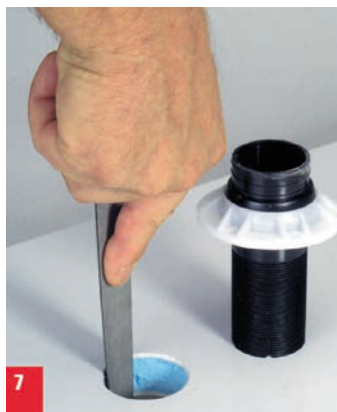
7. Loch ausfeilen. Dachdurchführung einsetzen.
