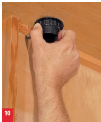
10. Rändelmutter von unten auf die Dachdurchführung schrauben.
