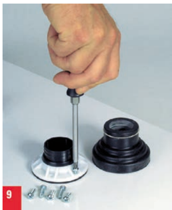
9. Schrauben eindrehen, ohne diese zu überdrehen.
