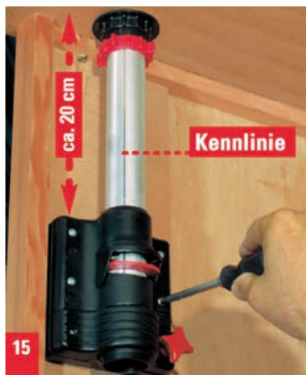
15. Schrauben anziehen. Dabei 20 cm Abstand zwischen Dach und Haltekonsole lassen.
