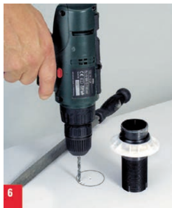
6. Wenn kein Kreisbohrer vorhanden ist, Loch von \varnothing 38 mm für die Dachdurchführung zeichnen und ausbohren.
